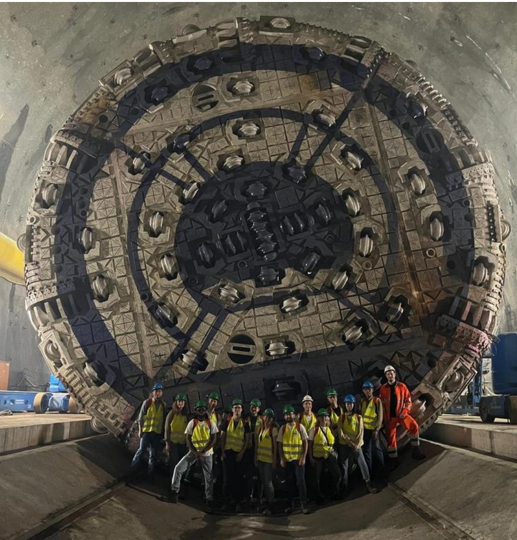
Aufgebaute D-TBM in Mauis, Baulos H53, Brenner-Basistunnel, 20.06.2024
