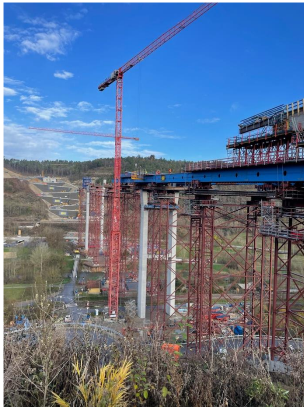
Abbildung 7 Baufortschritt der Talbrücke
