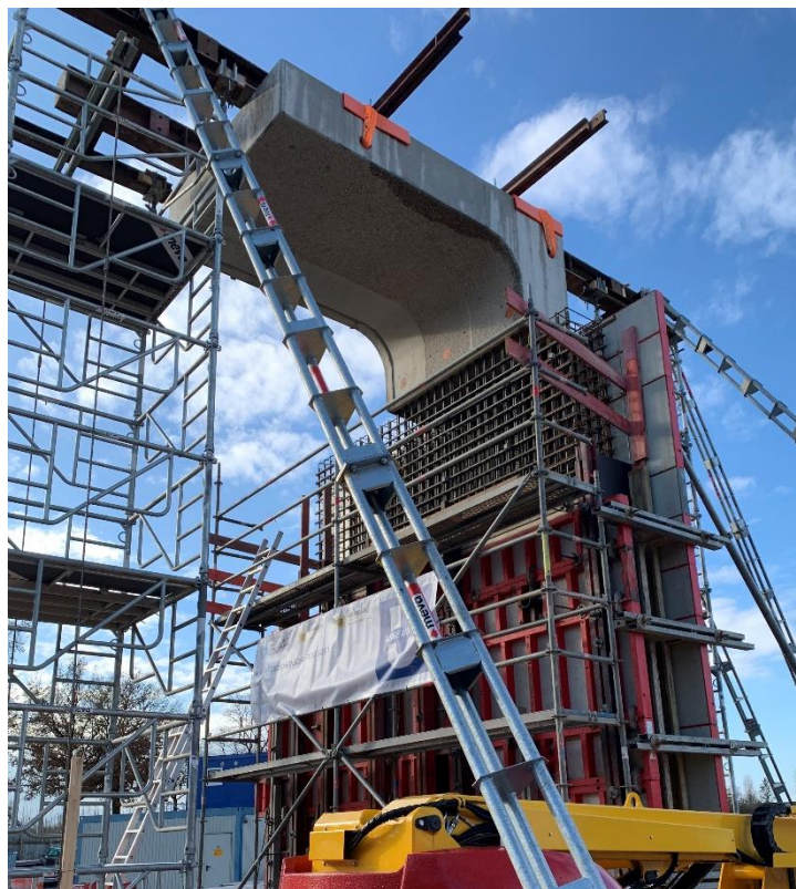
Abbildung 3 Probe-Betonage Tunneldecke
