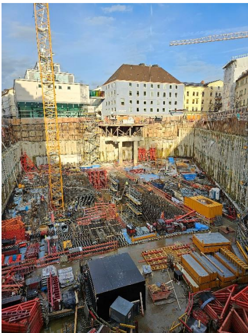
Abbildung 4 Totalansicht der Baugrube
