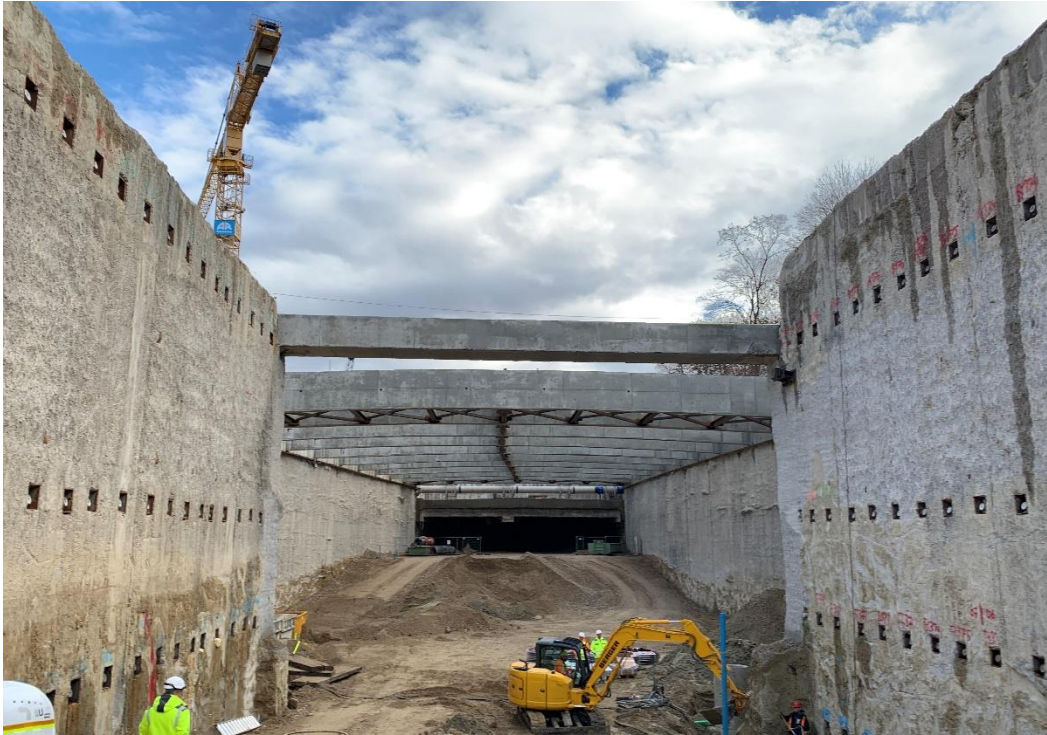
Abbildung 2 Aufweitungsbauwerk – Öffnung für Aushub mit Rampe zur Baustelleneinrichtungsfläche
