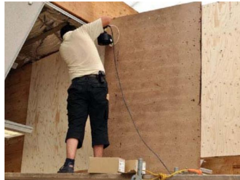
Aufkleben von Verstärkungsplatten [2]
