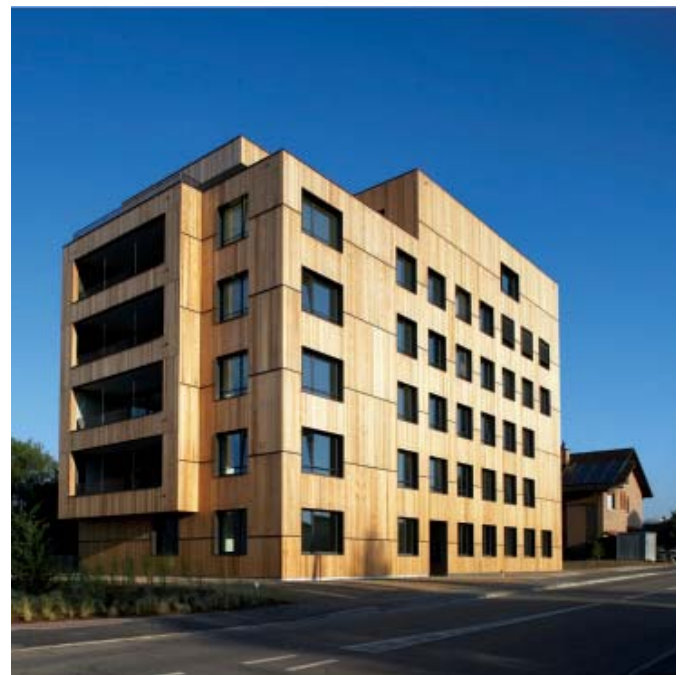
Mehrfamilienhaus, Zug, Schweiz.
