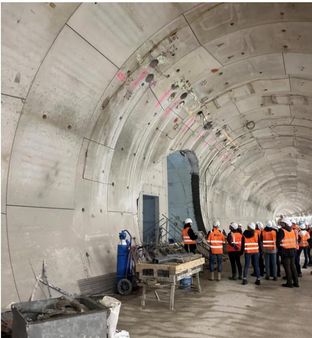
Abbildung 23: Querschlag zum Rettungsschacht
