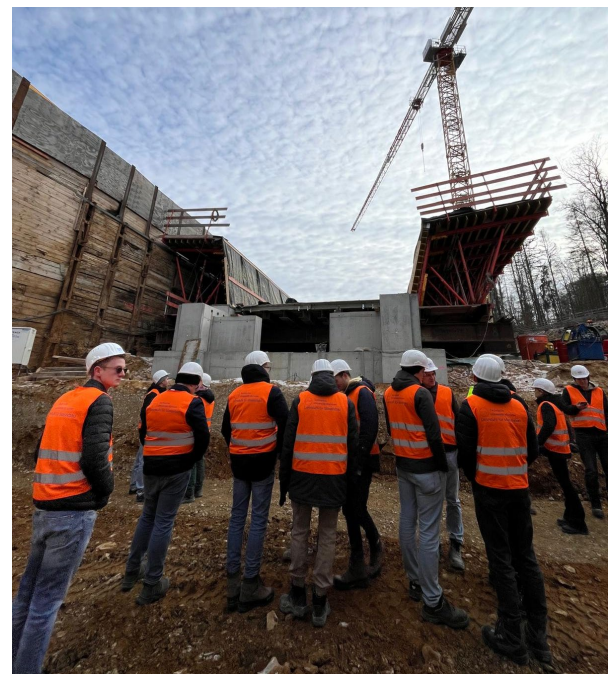
Abbildung 11 Taktkeller der Richtungsfahrbahn Regensburg
