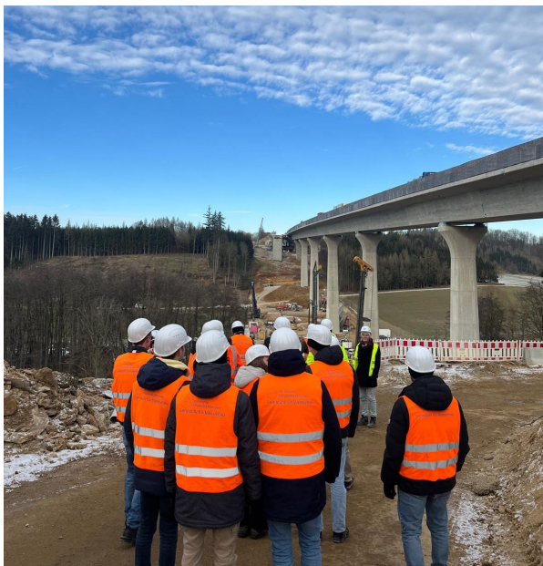
Abbildung 10 Blick auf das Teilbauwerk der Richtungsfahr- bahn Regensburg
