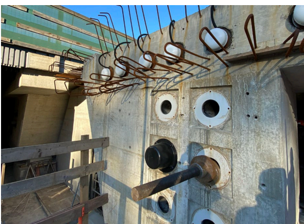
Abbildung 5 Verankerung der Spannglieder
