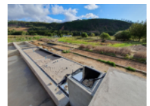
Abbildung 29: Das SMART-System im Water-Hub in Franschhoek, Südafrika
